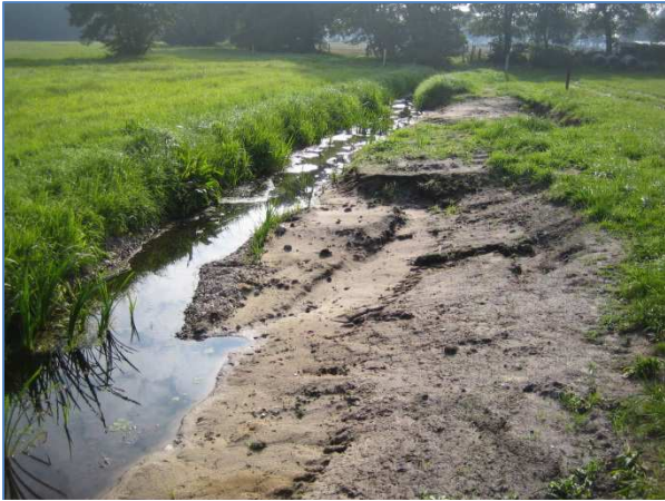
Böschungabflachung
