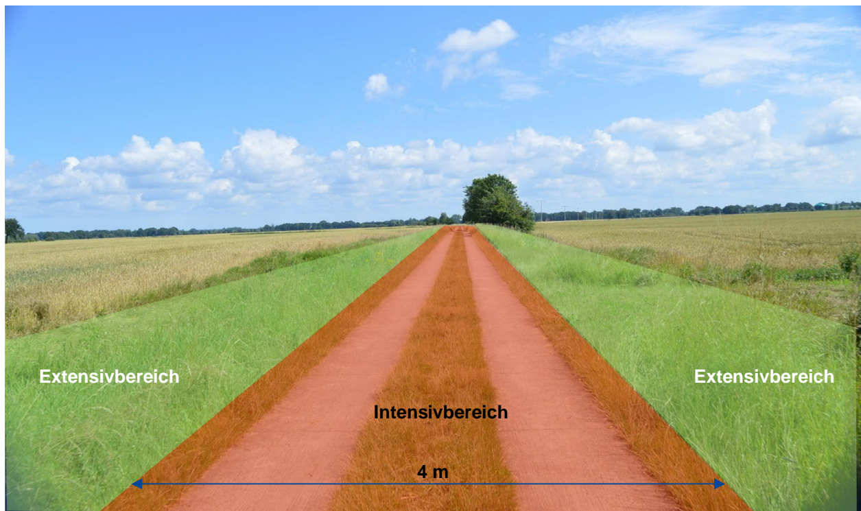
Abbildung 10: Wirtschaftsweg mit Betonspurbahn in Neu Wendischthun (Amt Neuhaus) mit Intensiv- und Extensivbereichen, Hintergrundfoto: Wirtschaftswegekonzept Stadt Bleckede, Ge-Komm GmbH (verändert)
