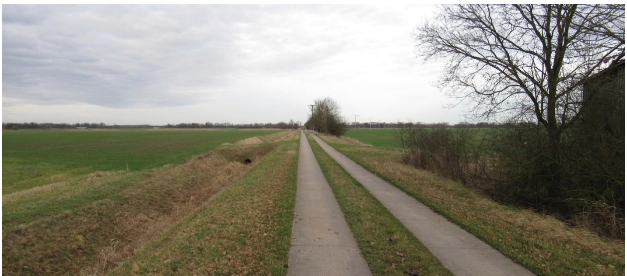
Abbildung 11: Linksseitig ein ausgemähter Graben II. Ordnung
