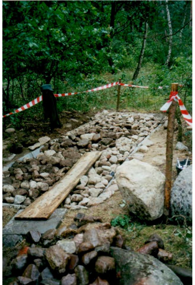
Bild 12: Das Becken wurde mit Steinen verfüllt und dann mit einer dünnen Schicht Waldhumus überdeckt.
