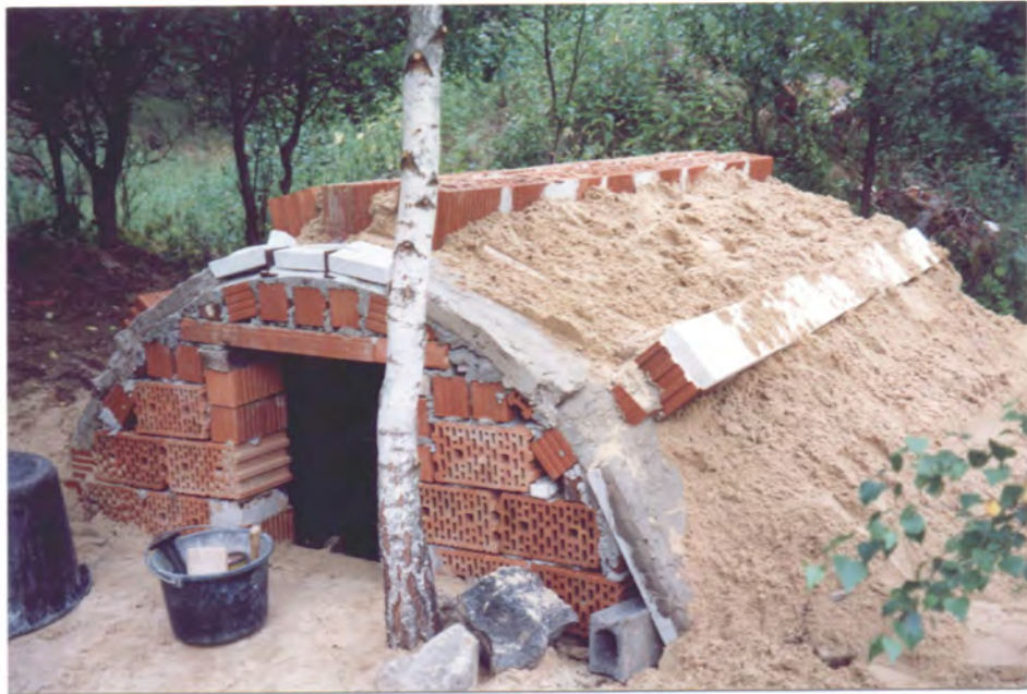
Bild 23: Deckplatten wurden auf die Porotonblöcke geklebt und die Übererdung erfolgte zunächst mit gewaschenem Sand von ca. 30 cm Schichtdicke und dann mit ca. 40 cm Mutterboden
