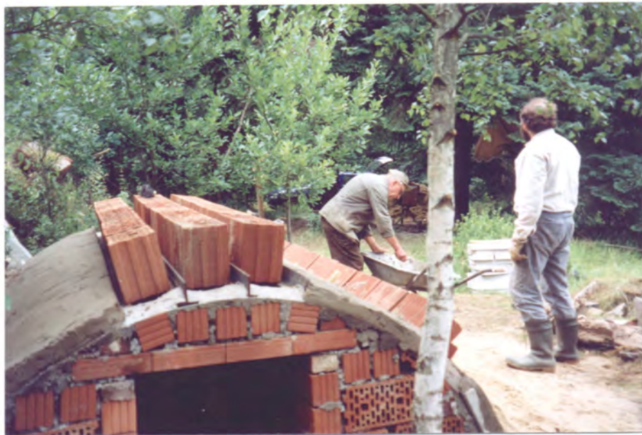
Bild 22: Porotonblöcke, die die Hangnischen für die Fledermäuse enthalten, wurden aufgelegt
