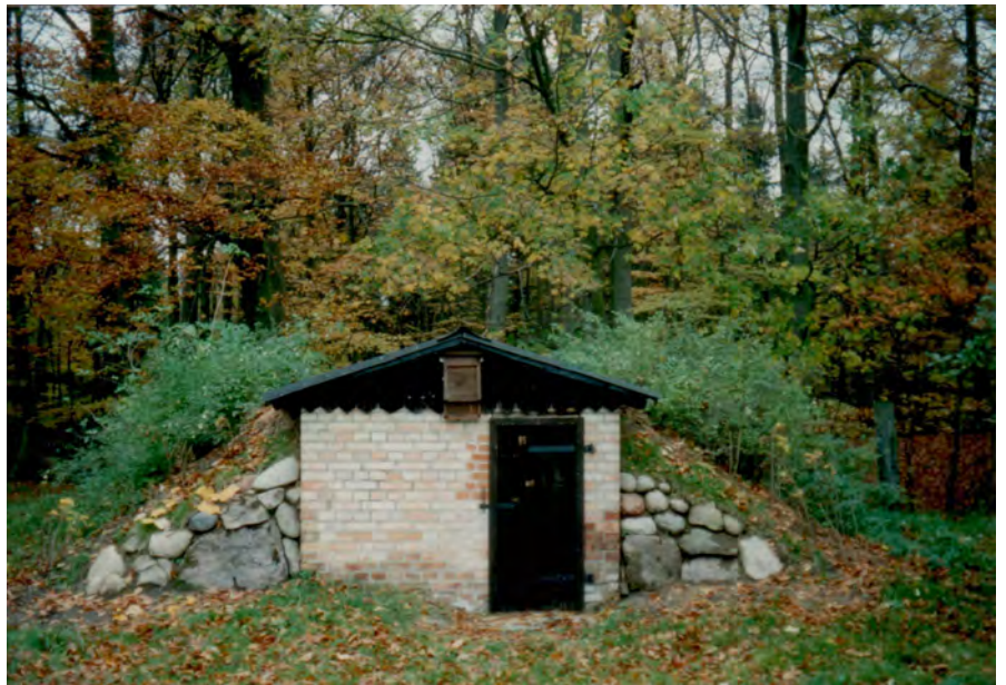
Bild 5: Brunnenhaus nach dem ersten Ausbau
