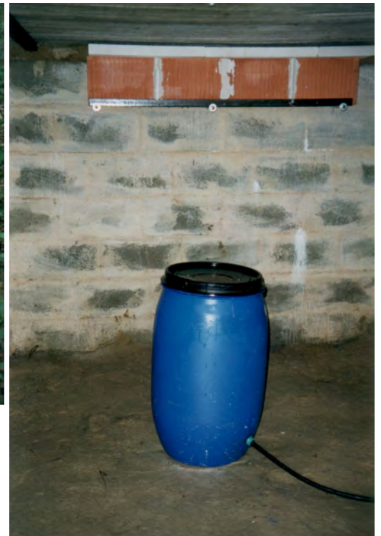
Bild 17: An der hinteren Wand ist unter der Decke eine Porotonbettenreihe zu sehen. Die Tonne sammelt das von der Regenfanganlage tropfende Regenwasser und verteilt es über einen Perlschlauch zu gleichen Teilen auf beide Räume.
