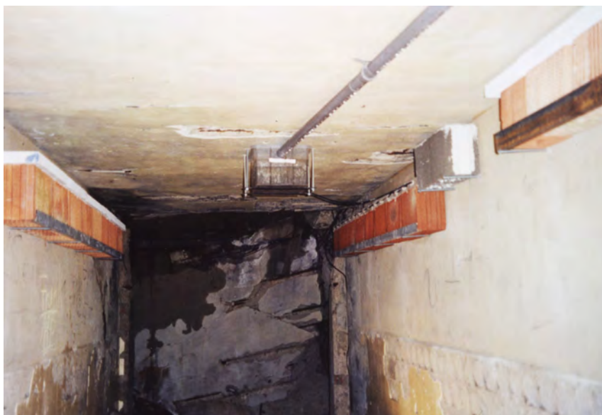
Bild 33: Rechts und links sind die Reihen der Versuchsbetten an den Wänden installiert. In der Mitte der Decke ist die Wasserzuleitung von der Regenfanganlage und ein Sammelbehälter zu sehen, von dem die rechte Bettenreihe durch einen Schlauch regulierbar bewässert wird.
