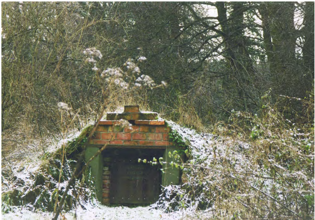
Bild 4: Kontrolleingang zum Stollen
