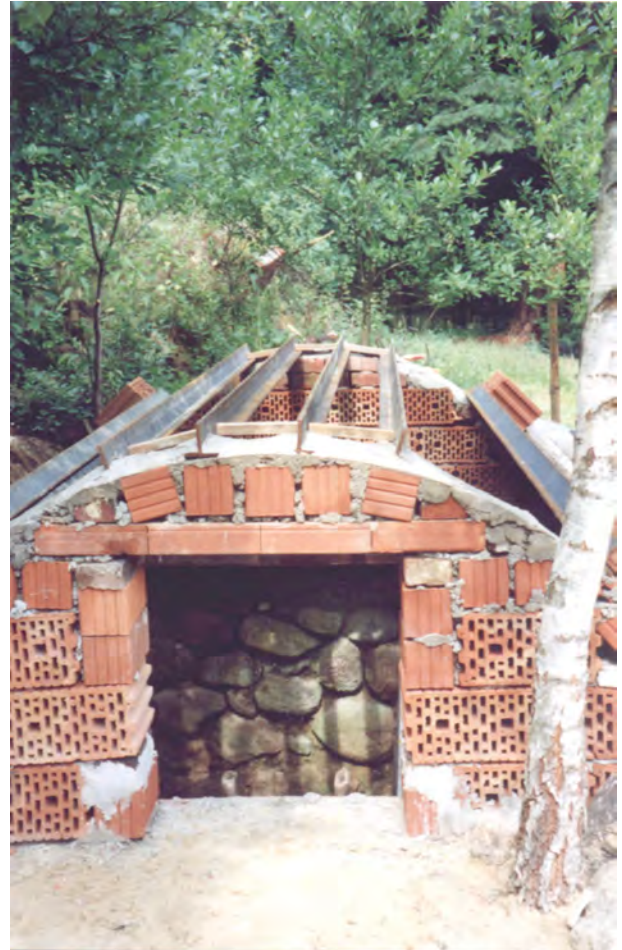
Bild 21: Aufgelegte Stützträger für die Porotonblöcke
