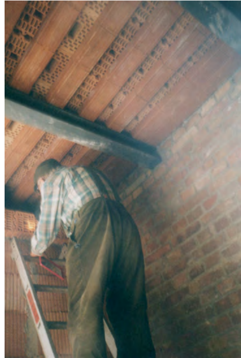
Bild 8: Der Blick auf die Ausbaudecke zeigt die Ziegelstürze, die als Auflage für die Porotonbetten verwendet wurden.
