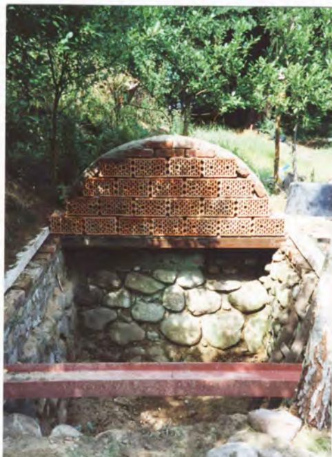
Bild 19: Hinterer Gewölbegiebel fertig
