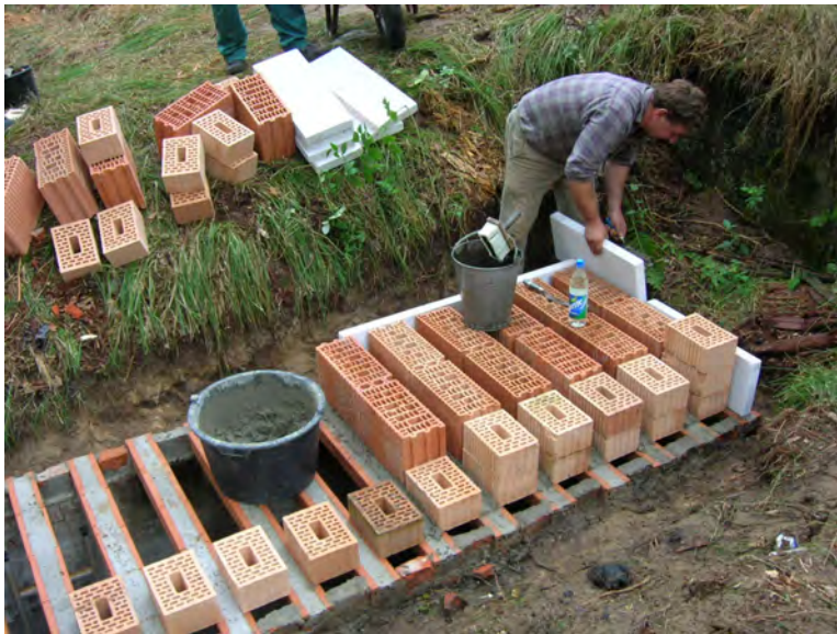
Bild 13: Aufbau der Decke aus Porotonbetten und Beginn der Einkleidung mit Porenbetonplatten
