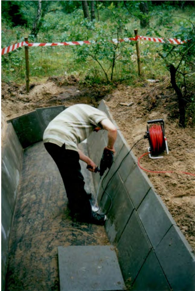
Bild 11: Das Regenfangbecken wurde direkt im Zenitbereich über dem Gang gebaut.
