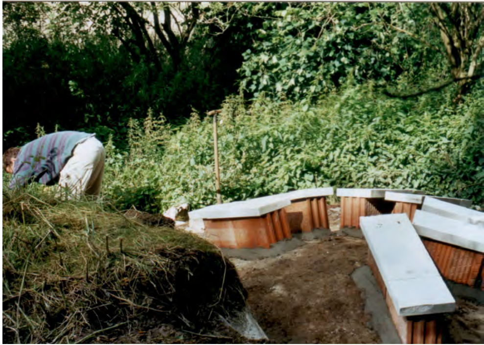
Bild 3: In die Betondecke wurden Öffnungen geschnitten, auf die die Porotonbetten gemauert wurden
