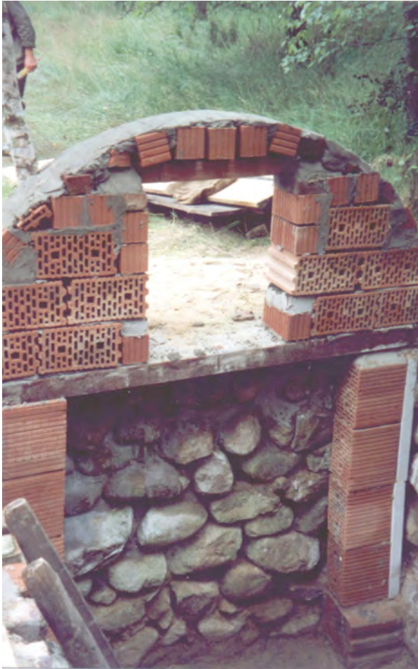
Bild 20: Vorderer Gewölbegiebel mit Kontrolltüröffnung
