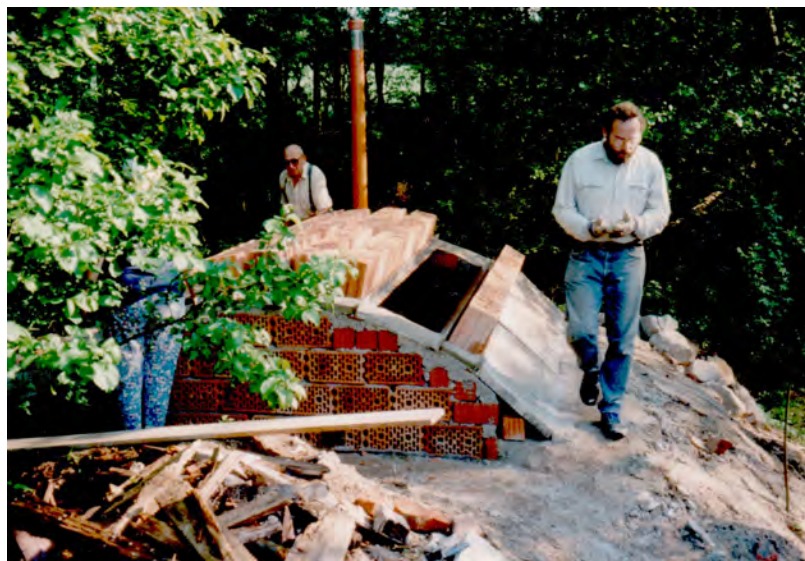
Bild 2: Gewölbedecke im Bau. Porotonblöcke mit eingearbeiteten Nischen sind aufgelegt, im Hintergrund ist das Lüftungsrohr sichtbar.
