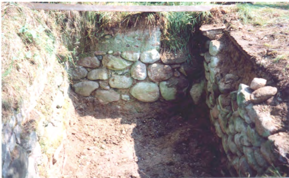
Bild 18: Begonnen wurde mit der Reparatur der zum Teil eingestürzten Feldsteinwände
