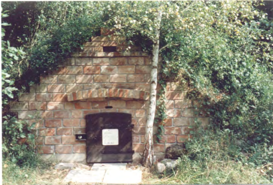
Bild 27: September 97: Frontansicht des fertigen Quartiers, zwischen Tür und Bogen ist der Einkriechschlitz für die Fledermäuse erkennbar. Rechts neben der Birke befindet sich die durch Steine verdeckte Öffnung für die Molche.
