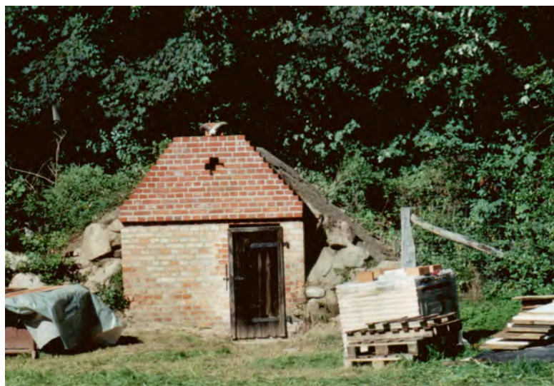
Bild 9: Das Brunnenhaus nach dem 3. Ausbau.
