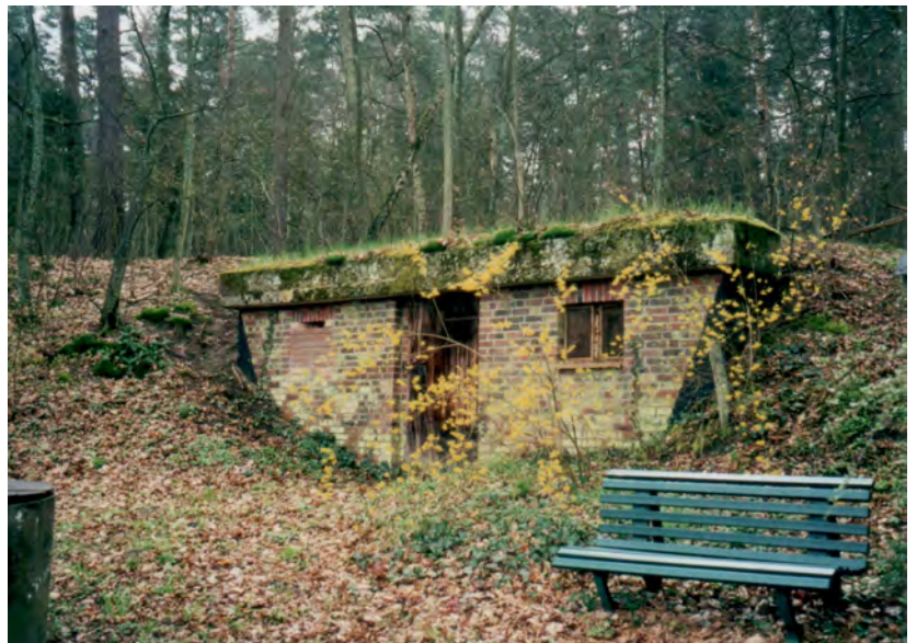
Bild 15: Ansicht von der Straße. Hier ist bereits das linke Fenster vermauert. Deutlich zu sehen ist der Einkriechschlitz für die Fledermäuse.
