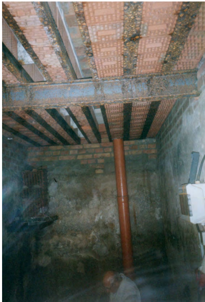
Bild 7: Deckenansicht mit den Porotonbetten. An der hinteren Wand das Lüftungsrohr.
