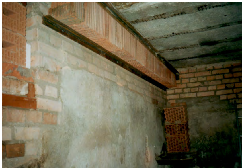
Bild 6: Die linke Reihe von Porotonbetten ist unter der Decke angebracht.
