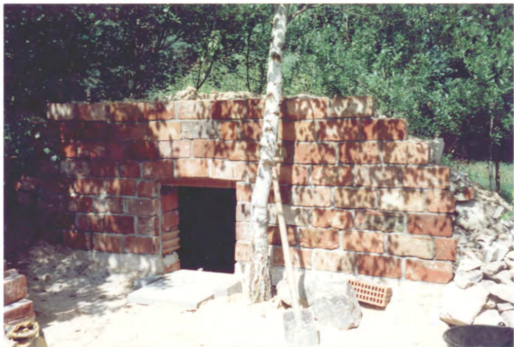
Bild 24: Beginn der Vormauerung der Giebelwand mit alten Reichsziegeln
