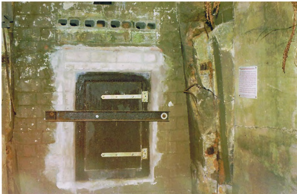
Bild 34: Betontür zum Winterquartier Hitzacker Faßkeller unmittelbar nach der Umrüstung
