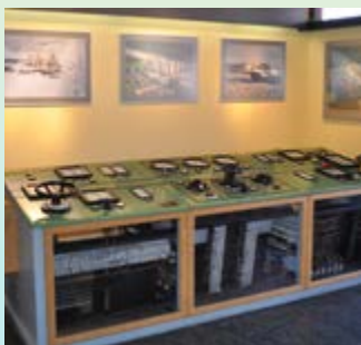
Historisches Steuerpult Schleuse Sülfeld
