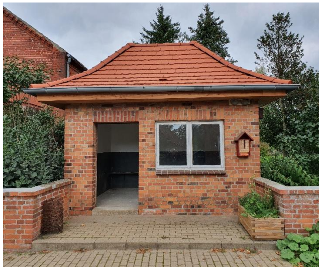
Abbildung 11: Mit neuem Dach
