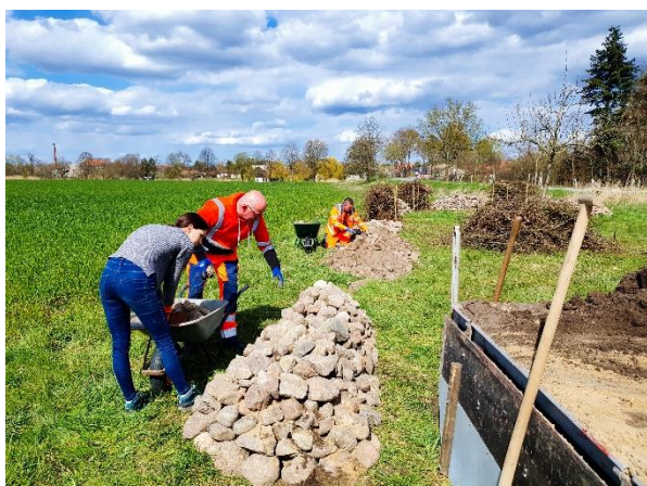
Abbildung 22: Freiwillige Helfer beim Bau der Steinwälle
