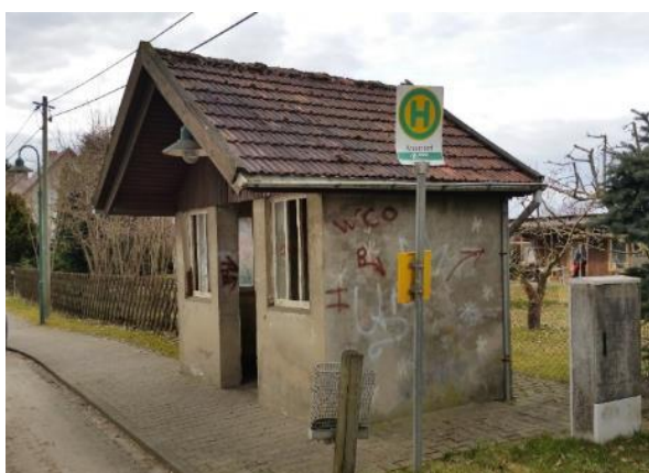
Abbildung 4: vor der Sanierung
