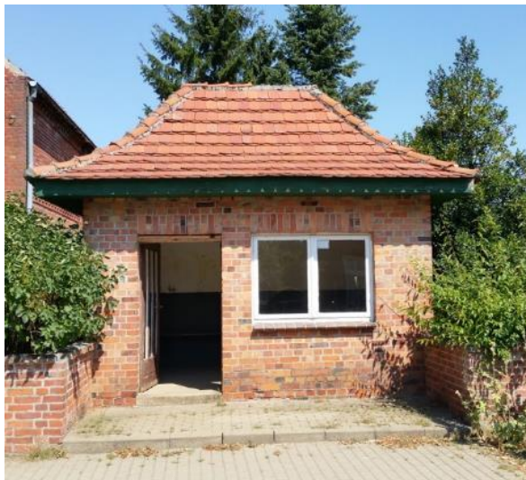
Abbildung 10: Vor der Sanierung
