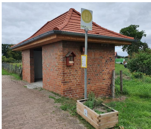
Abbildung 15: Nach der Sanierung (barrierefrei)
