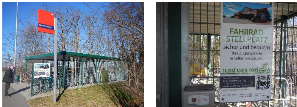
Abb. 27 Beispiel gesicherte Abstellanlage Station Bookholzberg, Gemeinde Ganderkesee
