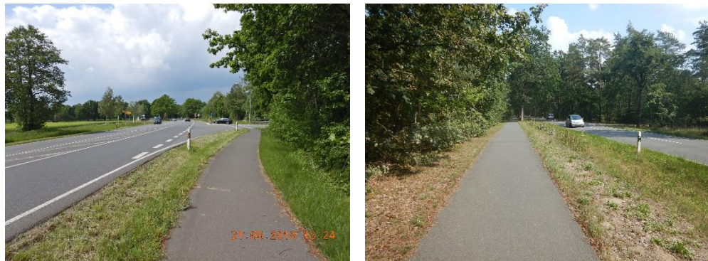
Abb. 19 Beispiele für Radwege im Bestand (Pendler Routen) an der K 46 bei Handorf (links) und der L 216 westlich von Reppenstedt (rechts)
