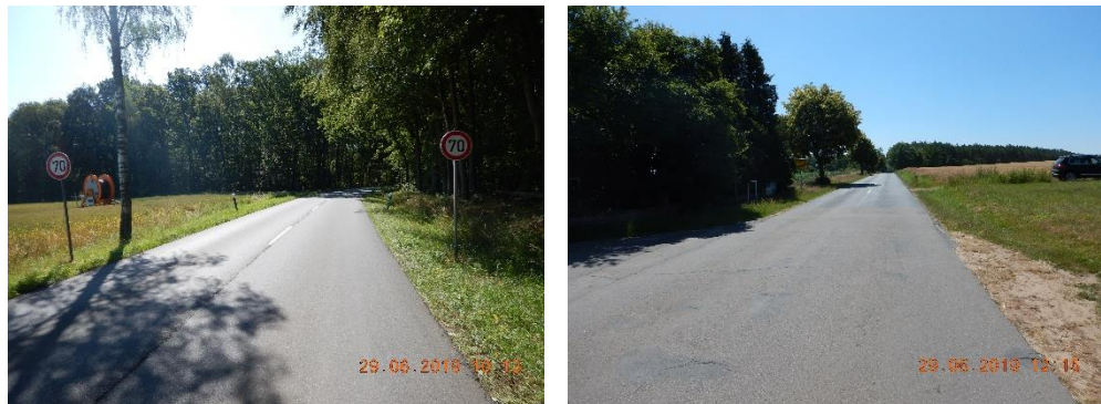
Abb. 14 Beispiele für Netzlücken an der K 28, südlich von Nutzfelde (links) und an der K 35, südlich von Ellringen (rechts)
