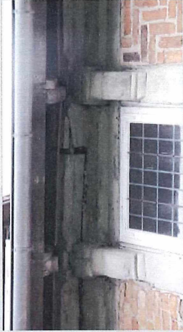
gebrochene Dachschwelle
