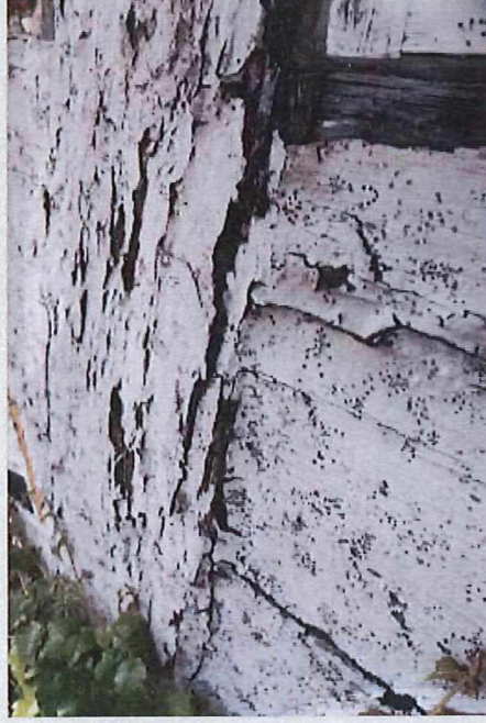
gebrochene Dachschwelle
