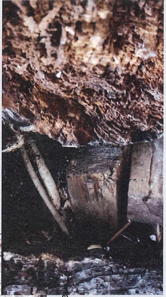
Verfaultes Holztragwerk Fassade
