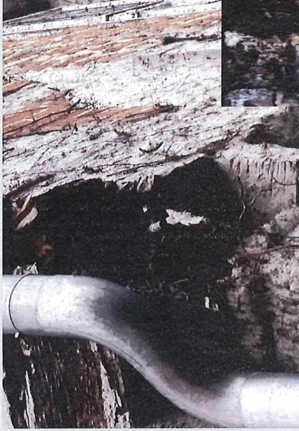
Verfaultes Holztragwerk Fassade
