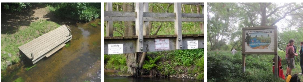
Abbildung 6: Beispiele für Mängel an Stegen und Schildern
