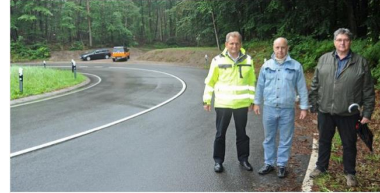
Andreas Dobslaw von der Polizei (v.l.) sowie Dirk Bonow und Rüdiger Scholz vom Landkreis Lüneburg stehen in der Spitzkehre an der Kreisstraße zwischen Alt Garge und Walmsburg. Seit kurzem gilt dort ein neues Tempolimit. Foto: cw
