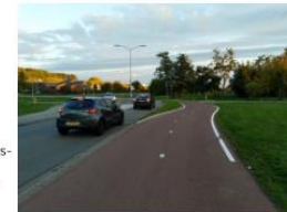
Zielbild selbstständig geführter Zweirichtungsradweg im ländlichen Bereich (Beispiel aus Nijmegen/Niederlande)
