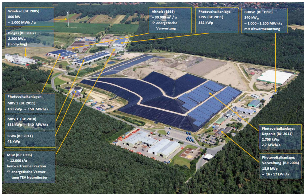
Abbildung 33: Energieerzeugung im Entsorgungszentrum Bardowick (Energieauditbericht 30.01.2020)
