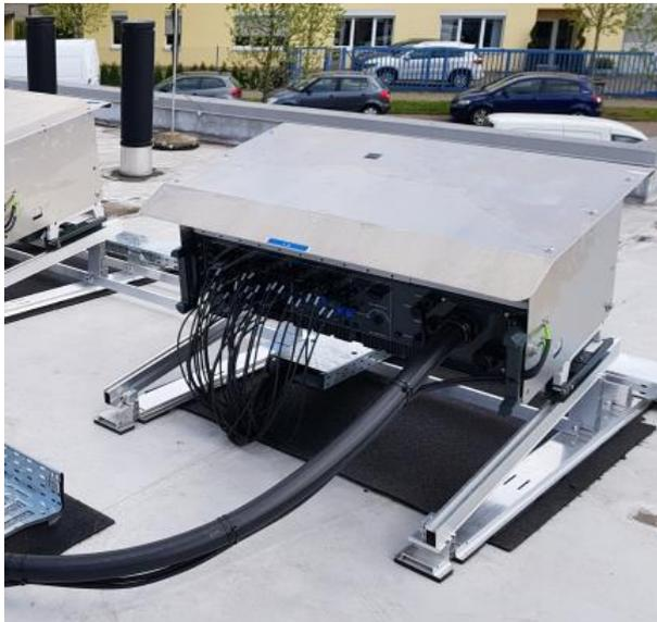
Abbildung 2: Wechselrichterunterkonstruktion
