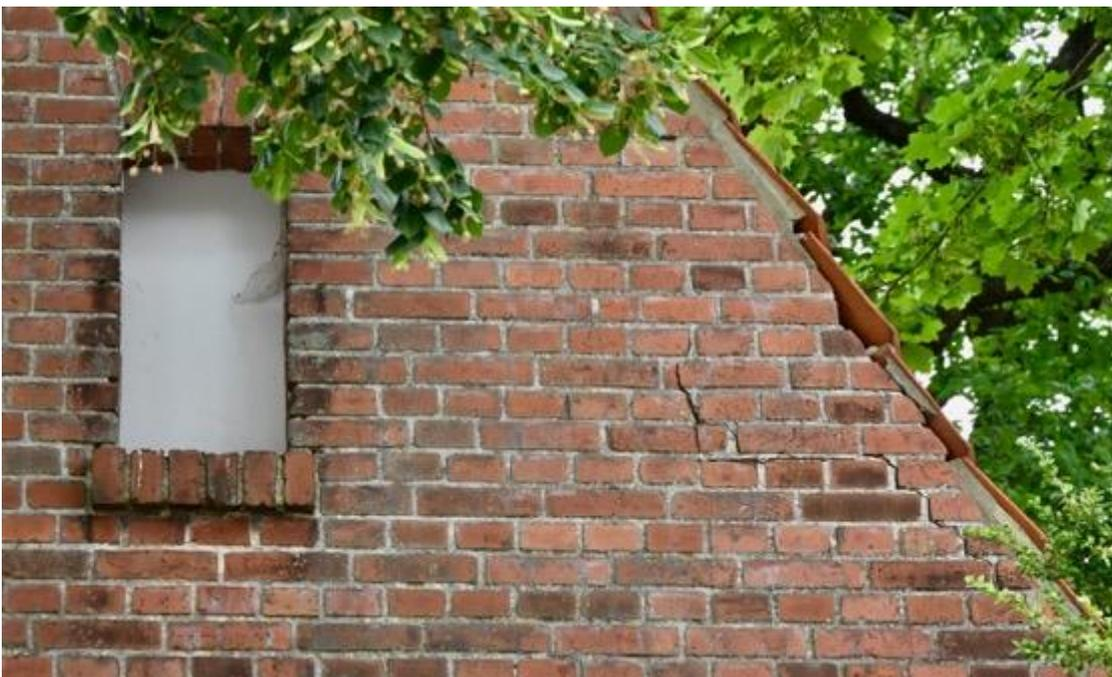
Foto 3.3: Fassadenriss Westgiebel und mangelhafte Andichtung der Dachdeckung
