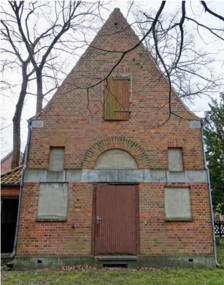
Foto 8.7: Nebeneingang Ostgiebel, die kleinen Putzflächen sind vermauerte Fenster, die großen in den 60er Jahren eingebaute Nischen
