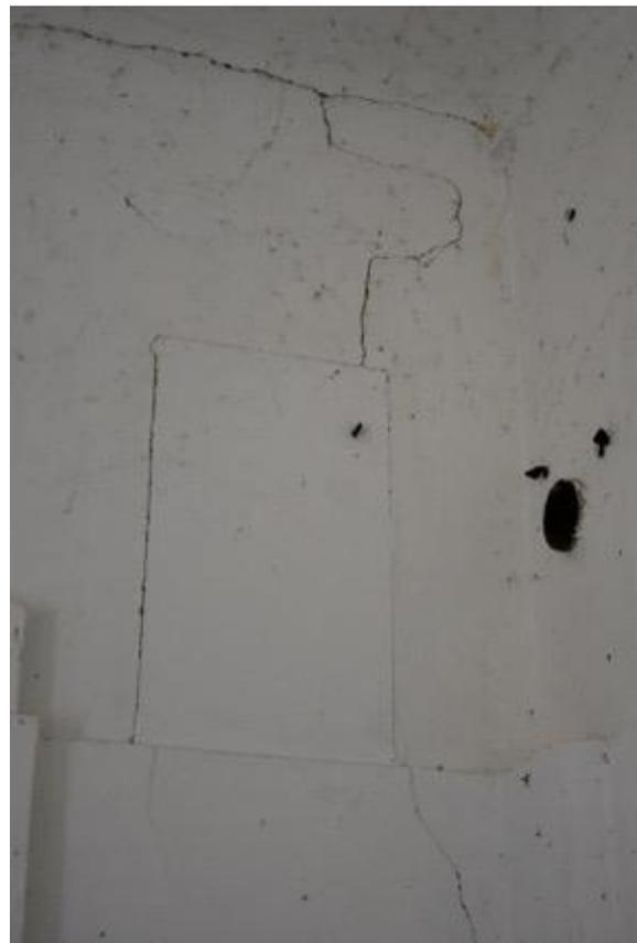
Fotos 3.13 und 3.14: Durchgehende Wandrisse Nordostecke und Südostecke mit den vermauerten Fensteröffnungen
