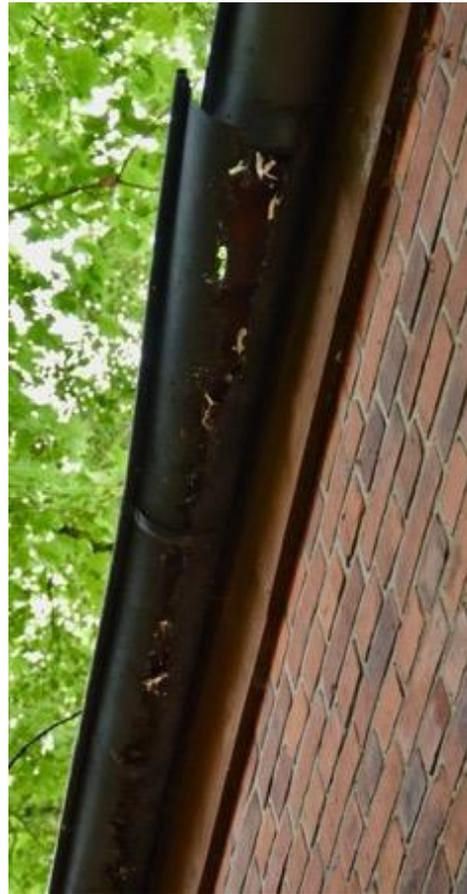
Fotos 3.4 und 3.5: Mangelhafte Dachandichtung an die Fassade und vollständig korrodierte Regenrinne
