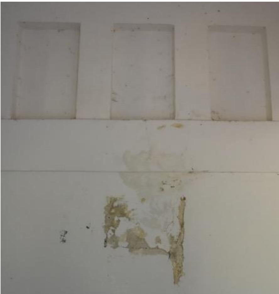
Fotos 3.10 und 3.11: Feuchtigkeitsschäden in der Halle aufgrund schadhafter Dachentwässerung
