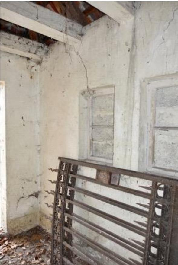
Foto 8.12: Inneres des Anbaues mit dem originalen, stark korrodierten Eingangstor
