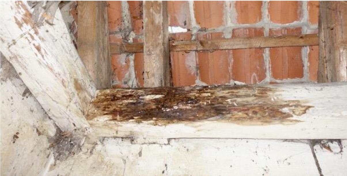
Foto 3.17: Durch Loch in der Dachdeckung geschädigter Deckenbalken im Anbau
