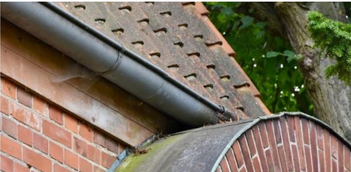
Foto 3.6: Schadhafte Andichtung der Dachrinne und der Abdeckung des Eingangs
